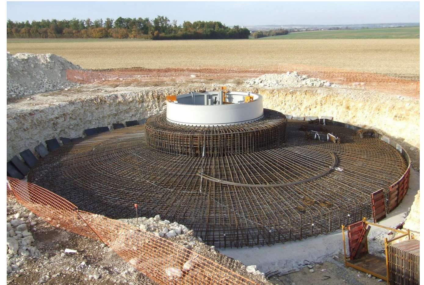
Photographie 7 Ferrailage d'une fondation
