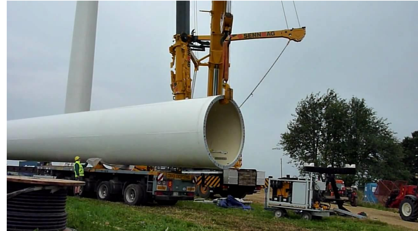
Photographie 4 Assemblage d'une section de tour
