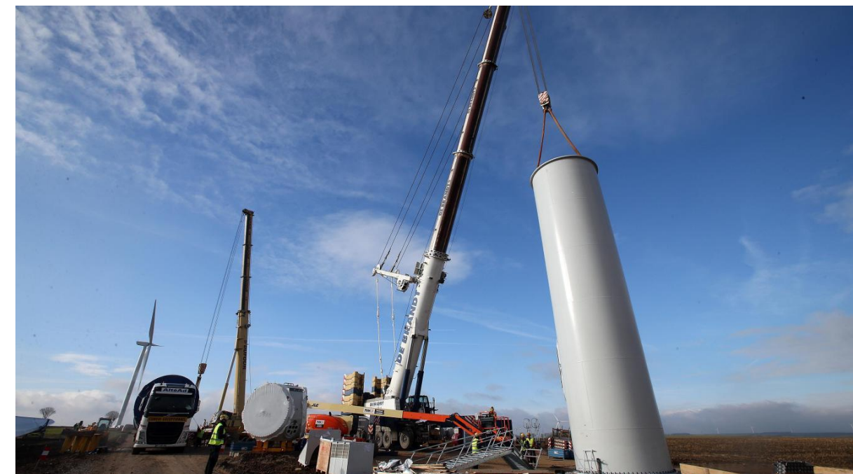
Photographie 9 Levage d'une section de mât
