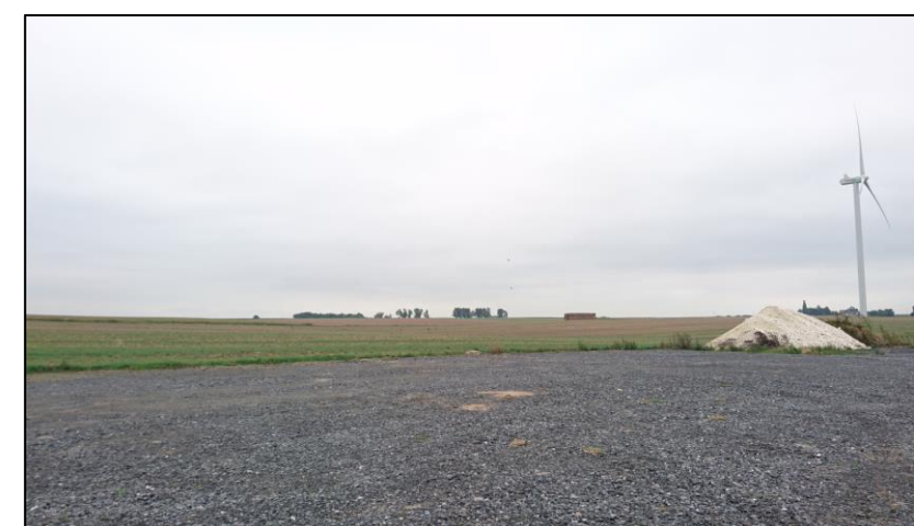
Photographie 23 Illustration d'un sol minéral appliqué à une plateforme de montage
