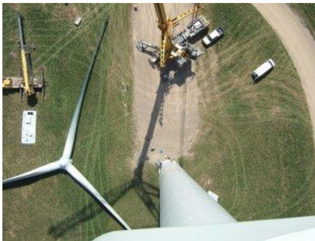
Photographie 8 Aire de grutage
