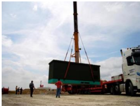
Photographie 5 Pose d'un poste de livraison
