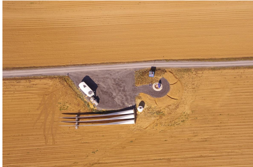
Photographie 6 Aire de montage
